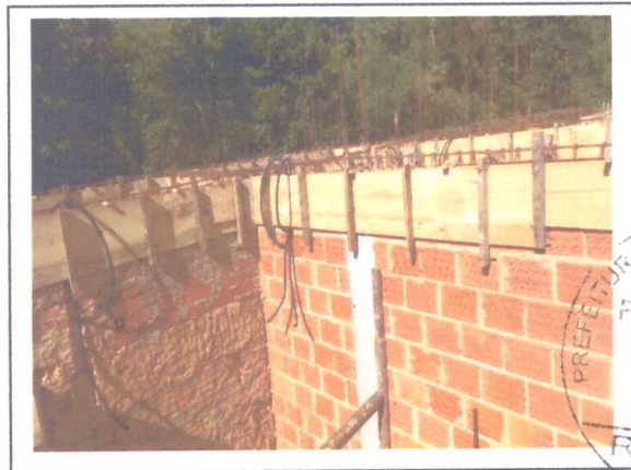
EXECUÇÃO DAS VIGAS
