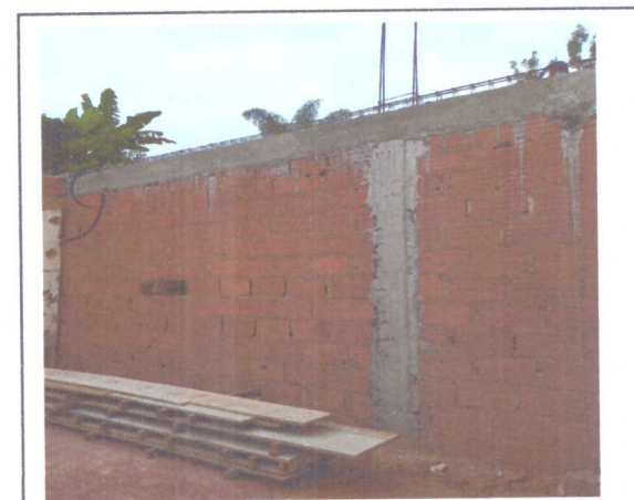
ALVENARIA E ESTRUTURA
