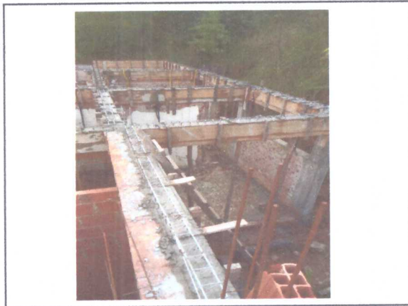
EXECUÇÃO DAS VIGAS
