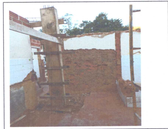
EXECUÇÃO DOS PILARES
